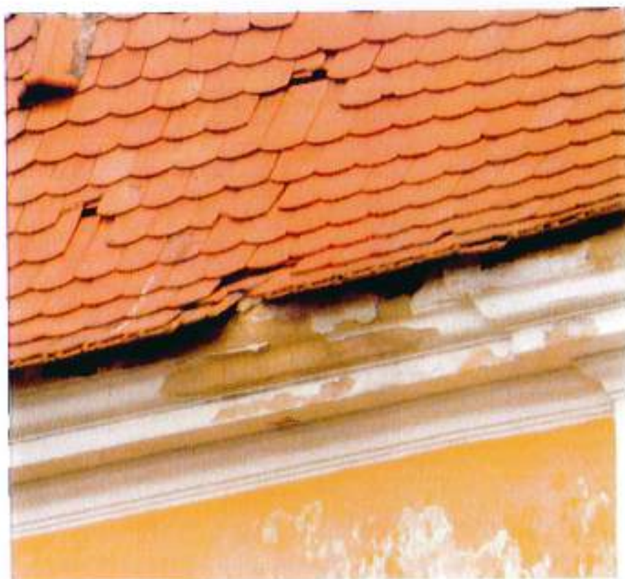
Fig. 6.- Detaliu cu cornișa distrusă din cauza execuției deficitare de terminației inferioare a învelitorii.
